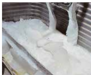
Oblodzenie urządzenia zewnętrznego bez ogrzewania tacy
