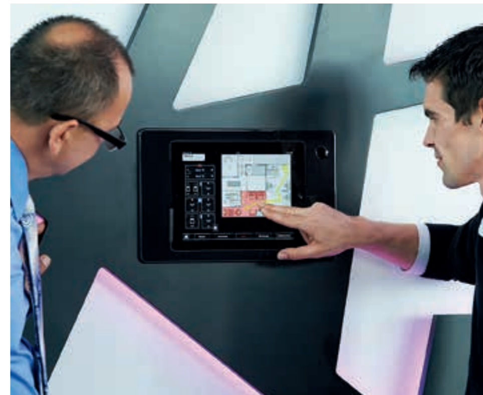
Instalacja połączona jest z automatyką budynkową KNX i obsługiwana z poziomu centralnego pulpitu sterowania KNX.
